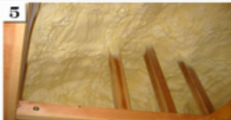
発泡系断熱材吹付け
