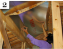
小屋裏から簡単にはめ込み
