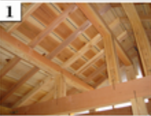
上棟後の小屋裏
