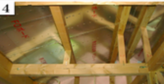
屋根タルキにタッカーでとめたFOボード
