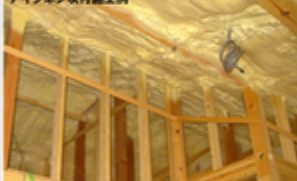
FOフォーム (はめ込み断熱) 施工例
