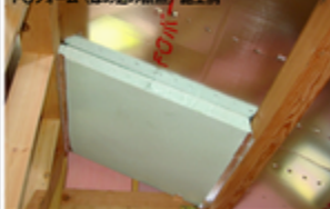
FOフォーム (はめ込み断熱) 施工例
